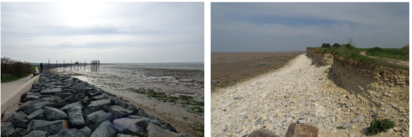
Figure 4 : Vue du pied de digue en limite nord du périmètre (à gauche) et du haut de la falaise du Rocher (à droite)
